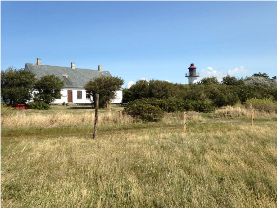
Foto 8. Hegn under opførelse ved lodshuset og fyret.
